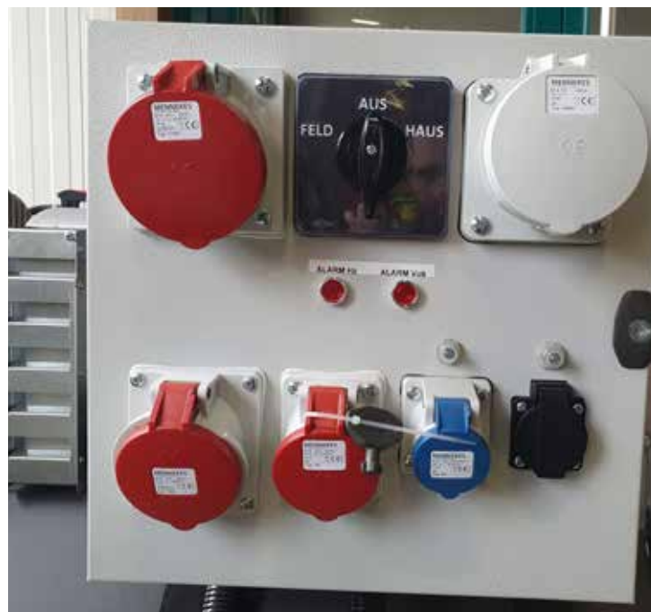
Anschlusskasten mit Feld/Hausbetrieb
