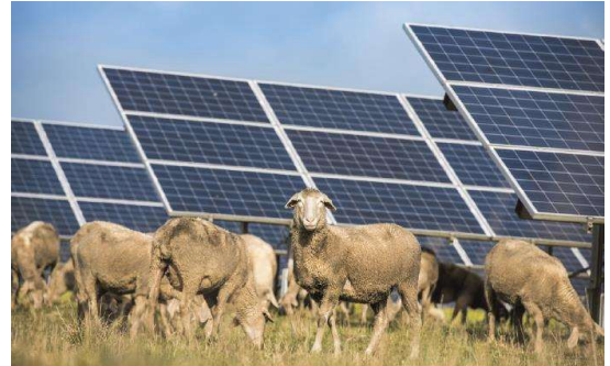
Schafherde grasst unter einer Freiflächen-Photovoltaikanlage..
